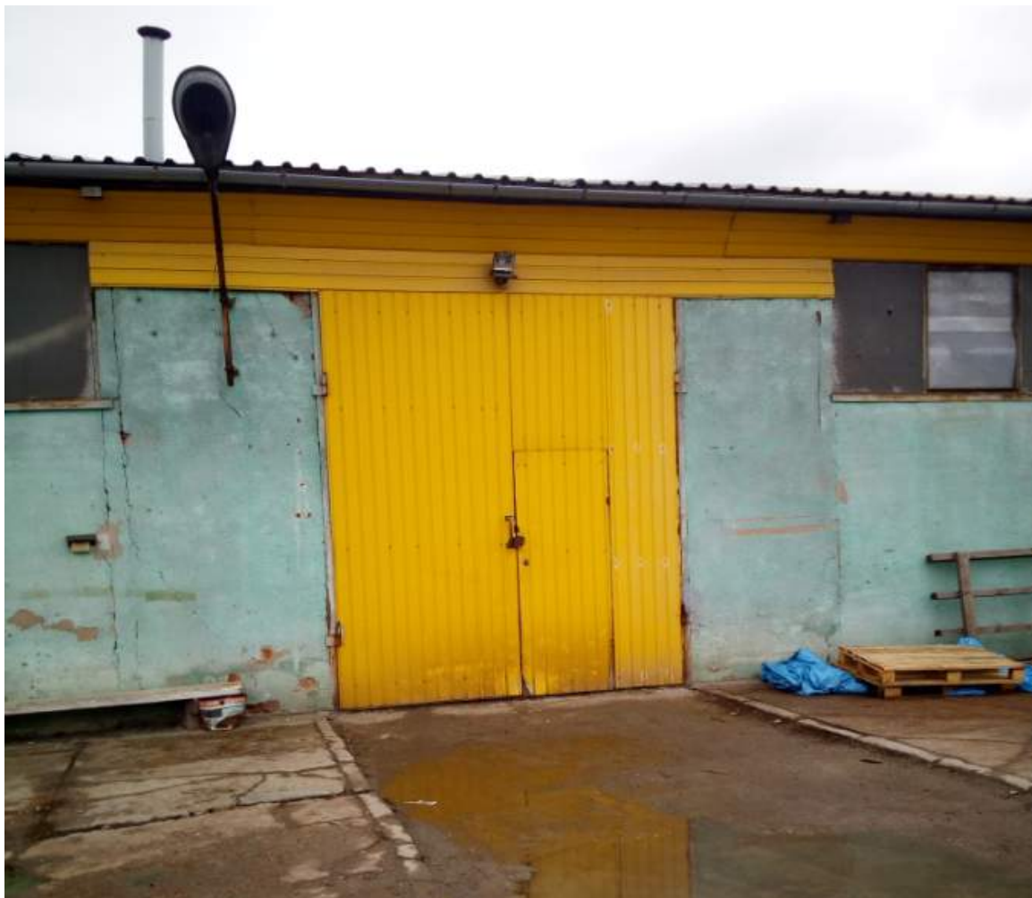
Brama wjazdowa do wymiany na segmentową podnoszoną mechanicznie. Widoczne naświetla do wymiany
